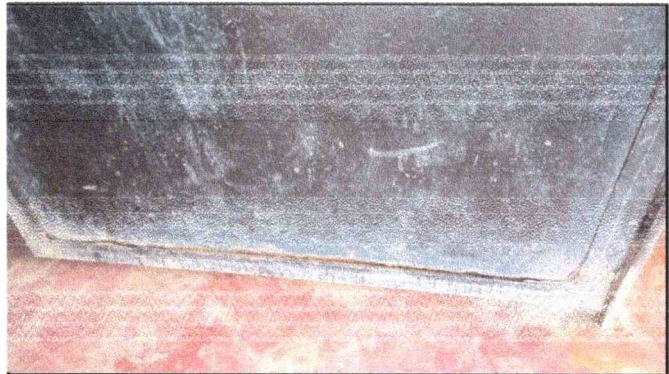
Foto 4: SUSTITUCION Y REPARACION DE PUERTAS
