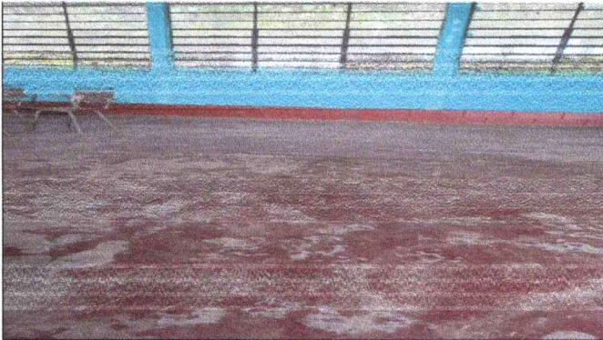
Foto 3: SUSTITUCION Y REPARACION DE PISO
